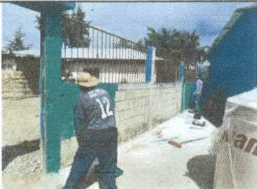
Foto 13: Pintura en muros exteriores
