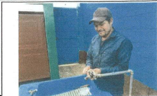
Foto 7: Sustitución de llave de chorro
