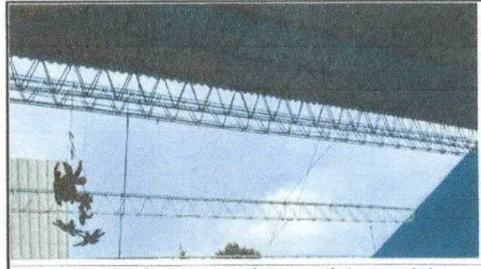
Foto No. 2: Sustitución de capote de lámina para lámina troquelada
